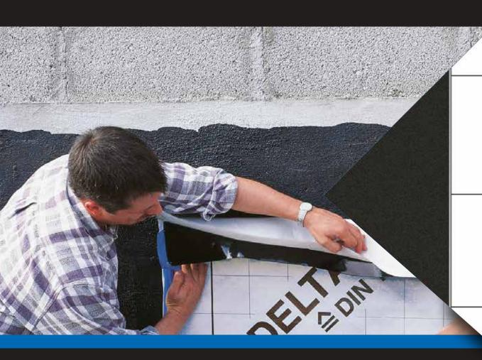
Гидроизоляционная мембрана высшего качества. Сертифицирована по EN 13969.
